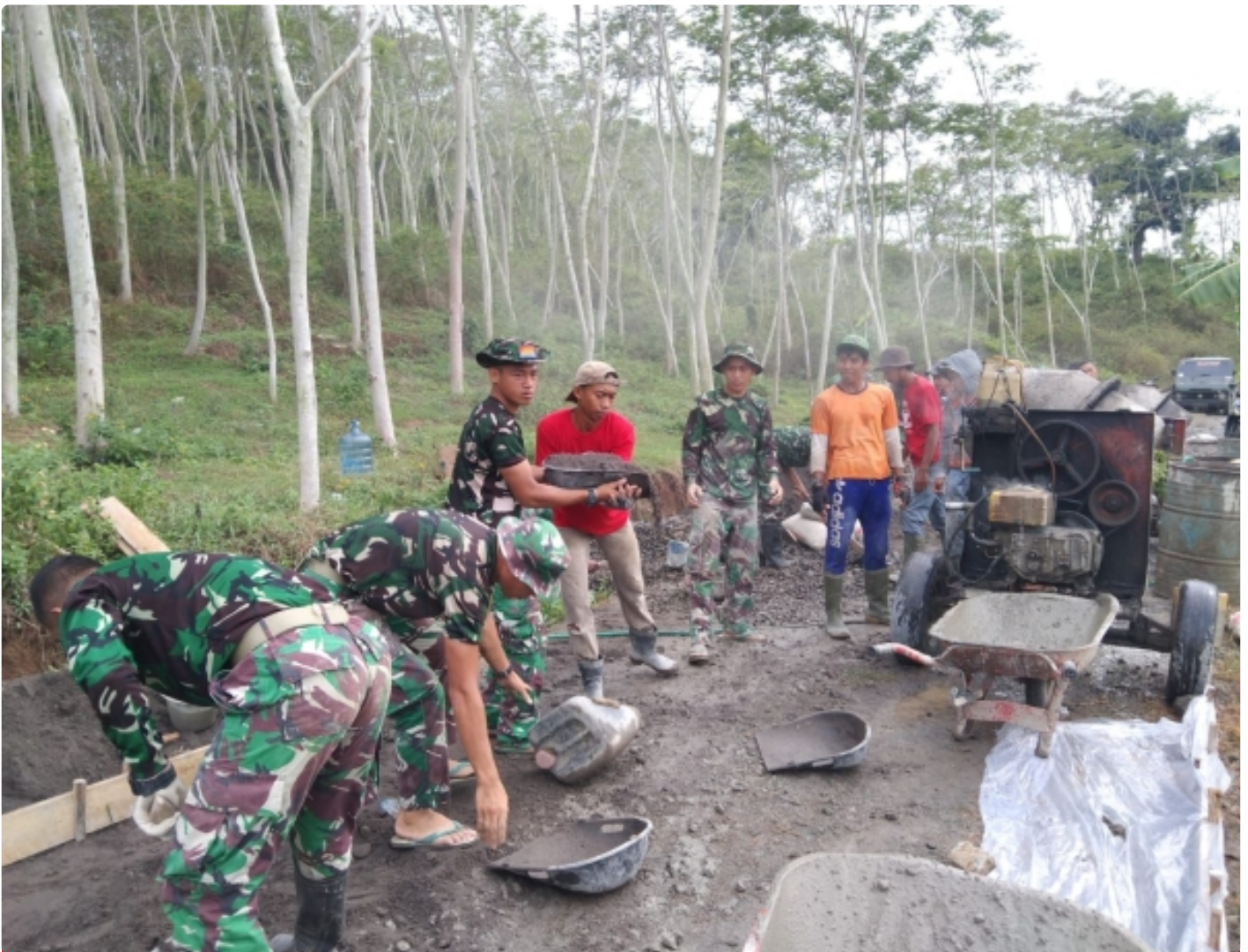
Satgas TMMMD Bersama Warga Bangun Pengecoran Jalan Penghubung Dukuh Grobogan Ke Area Pertanian.
